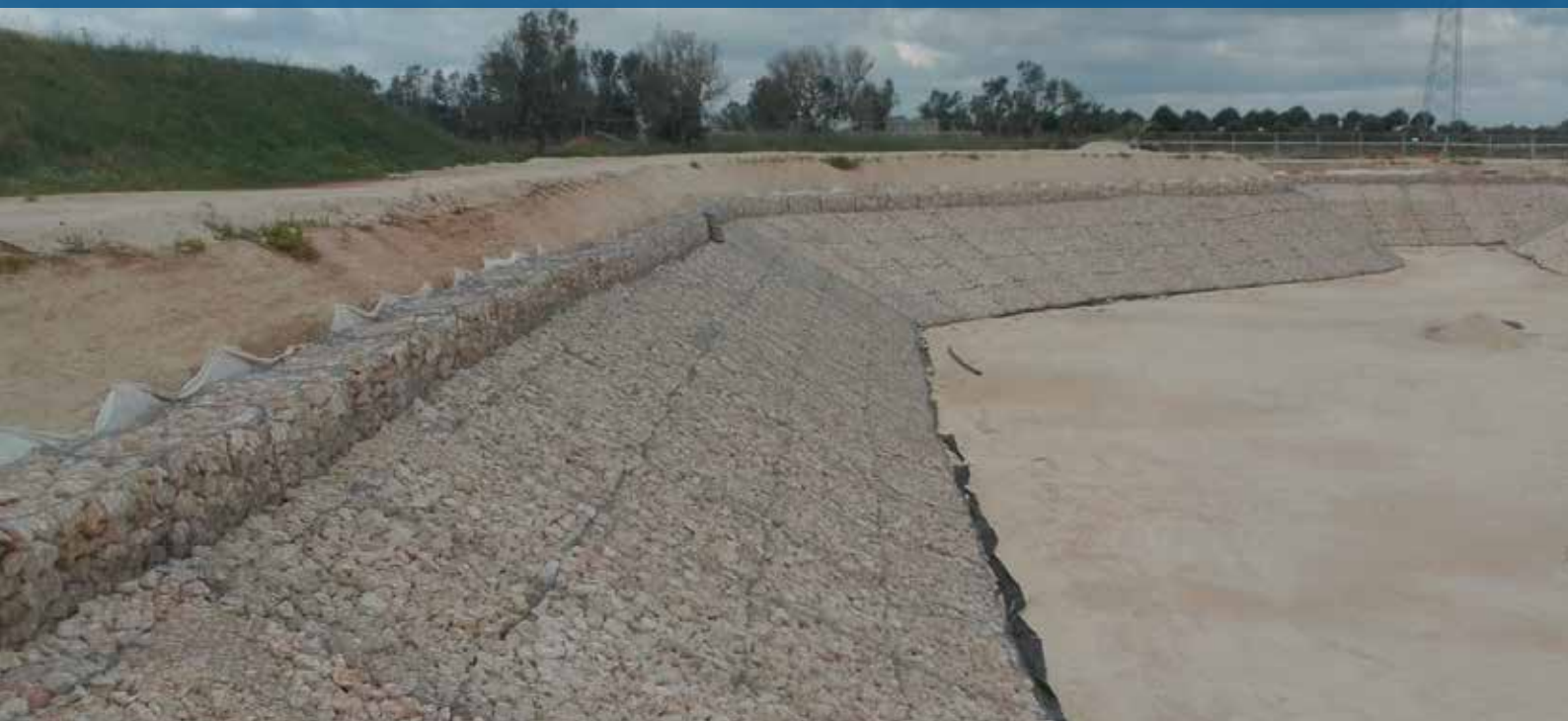
Potenziamento dell'impianto di depurazione di Castro (LE) - Italia Revamping WWTP plant of Castro (LE) - Italy
